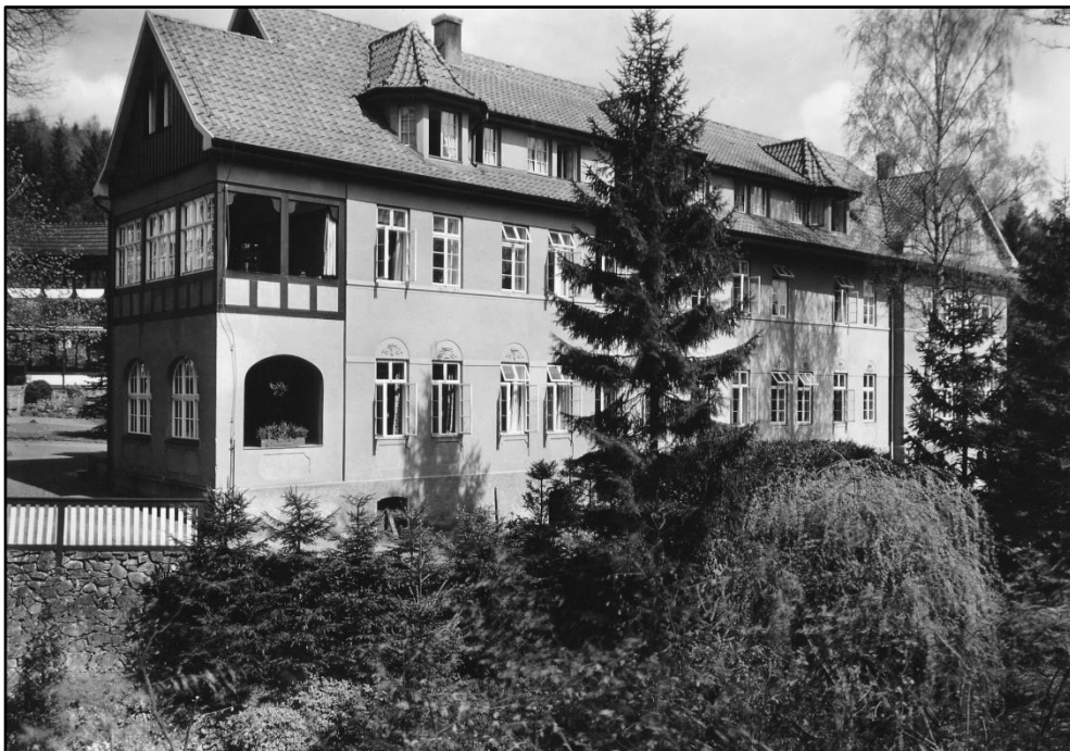
Abb. 8: Krankenhaus »Lebenswende« (Südhaus) *
